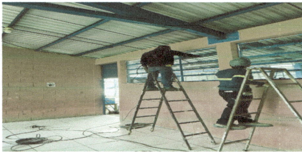
Foto: 3 desinstalaciones de ventanas de metal
