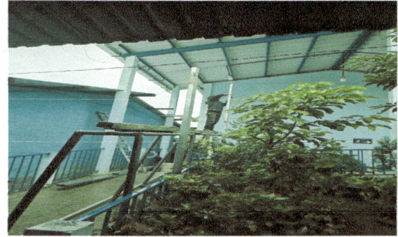
Foto: 2 lámina acanalada por lámina troquelada
