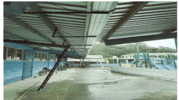
Foto: colocacion de canales y bajada de aguas pluviales
